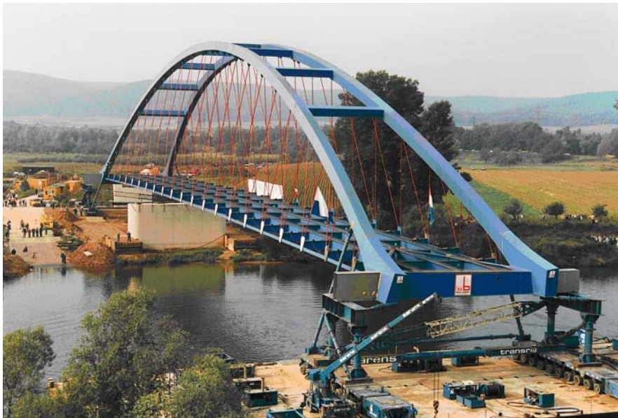
Abbildung 12: Einschwimmen einer Bogenbrücke über den Main
