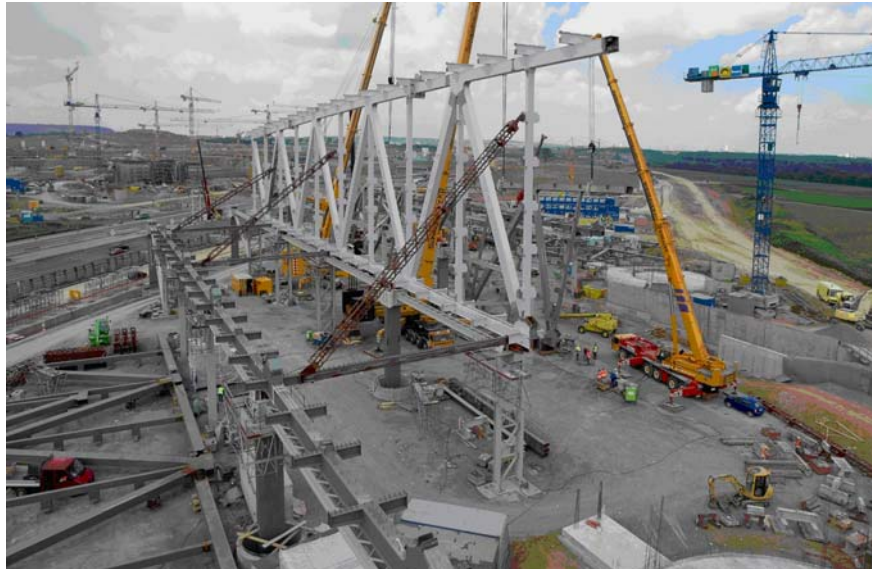
Abbildung 14: Beispiel Montagezustand: Absteifung des Fachwerkträgers auf dem Lehrgerüst
