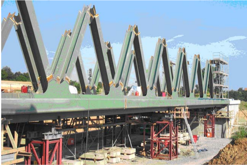
Abbildung 9: Fachwerkbrücke im Bauzustand auf Rüsttürmen
