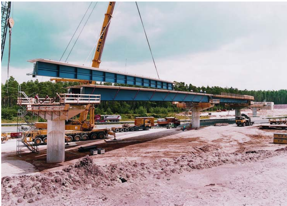
Abbildung 4: Versetzen von VFT-Brückenträgern
